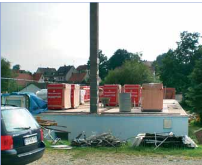
Gleich danach wird wieder aufgebaut.
