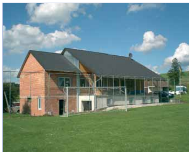
Am 25. Juli 2007 war endlich das Dach dicht.
