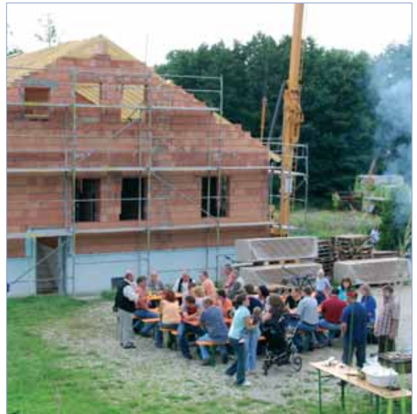
...und bald danach stehen die Giebelwände im Obergeschoß.
