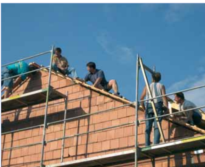
Dacharbeiten am 19. Juli
