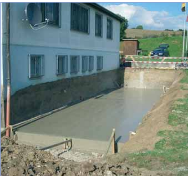
Am 23. August 2006 war das Fundament gelegt...
