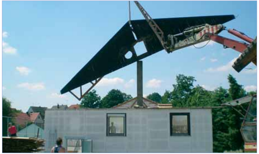
Das Obergeschoß wird abgebaut, verladen und vom neuen Besitzer abtransportiert.
