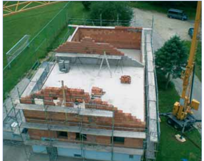
...und bald danach stehen die Giebelwände im Obergeschoß.
